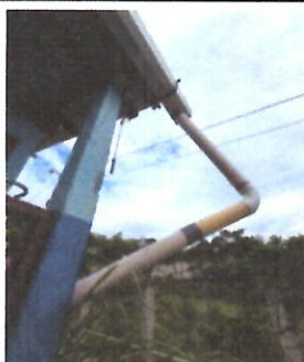
Foto 5: CANALES Y BAJADAS DE AGUA PLUVIAL
