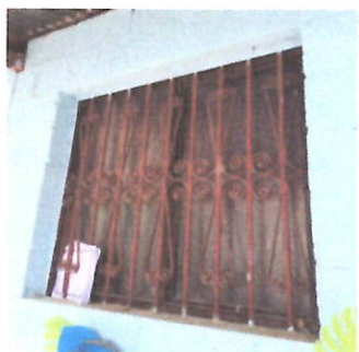
Foto 3: VENTANAS Reparación de balcones metálicos, incluyendo fijaciones, pintura y soldaduras. Aula 2
