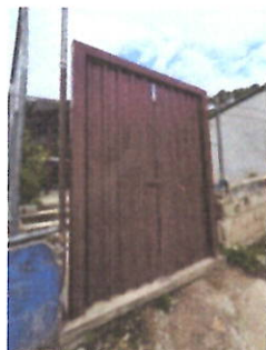
Foto1: MANTENIMIENTO A PORTONES
