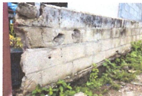
Foto 6: REPARACIÓN DE MUROS
