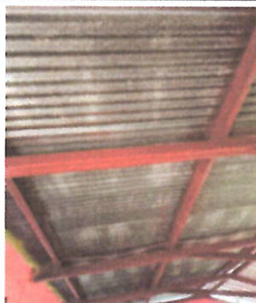
Foto 3: CUBIERTA DE LAMINA
