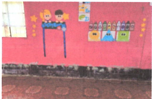
Foto1: PINTURA EN MUROS INTERIOR Y EXTERIOR Preparación de la superficie y aplicación de pintura a dos manos, en paredes interiores y exteriores del establecimiento e impermeabilización
