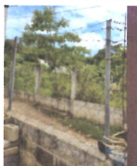
Foto 2: CERCO O MURO PERIMETRAL Sustitución malla de acero galvanizado en perímetro del establecimiento, con instalación fija y tensa, anclajes metálicos en intervalos regulares
